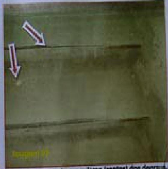
Imagens 56 e 57 - Mostrando as cantoneiras metálicas que guarnecem os segmentos angulares (cantos) dos degraus. Atenta-se para a sujidade (pó de cimento e/ou resíduos de argamassa e cimento e massa comida) acumulada nos pisos dos degraus.
